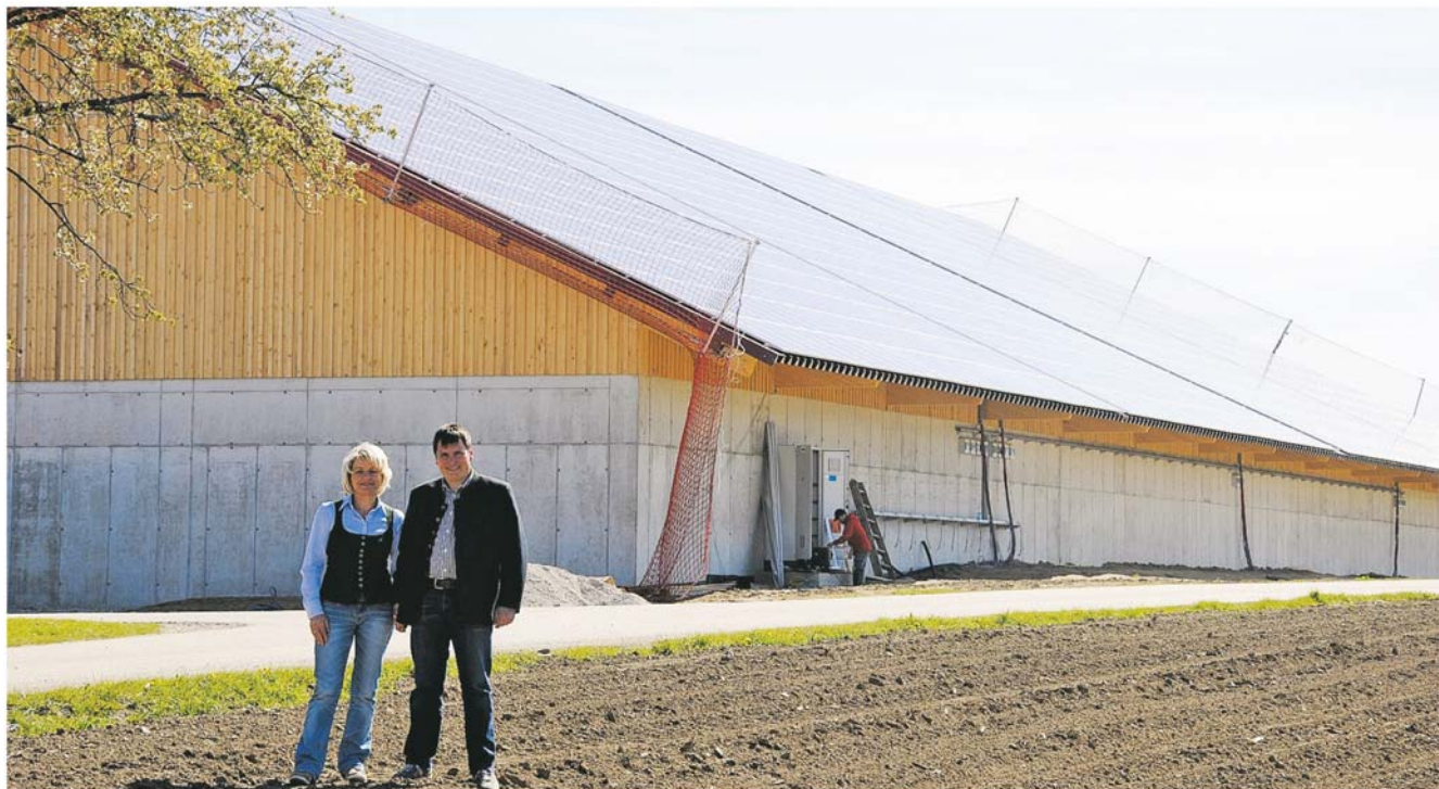
Eigens an die Bedürfnisse der Photovoltaik angepasste Hallen haben die Bauern der „Mostviertel Energie“ errichtet.
